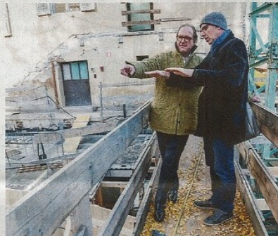
Sopraluogo all'interno del cantiere di Palazzo Campofranco
